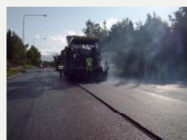
Fig 1. Lägghyt av referensgatan. Observera asfaltförläggningen.
