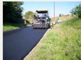
Fig 2. Lägghyt av asfaltmassa med Rediset WMX. Ängen är nytt asfaltförläggningen.
