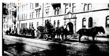
Bild 4. Läggnig av gjutasfalt på Strandvägen 1914 (Dufwa 1985).
